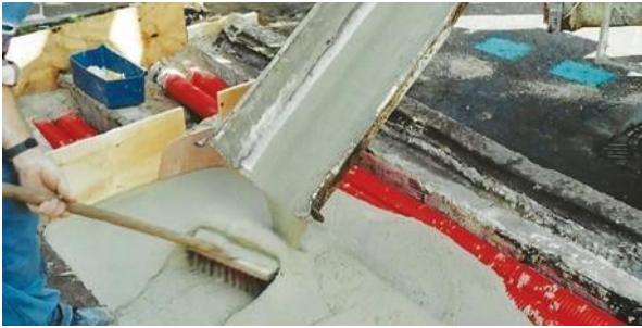
Isolation de canalisations ( \lambda=0.065 ) béton D0.3 facilement escavable.
