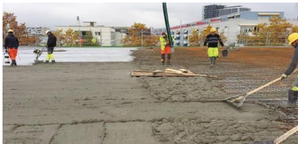
Forme de pente sur toitures et terrasses accessibles ou non, densité à partir de 300 kg/m 3
