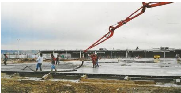
Isolation de canalisations ( \lambda=0.065 ) béton densité à partir de 300 kg/m 3 facilement escavable.
