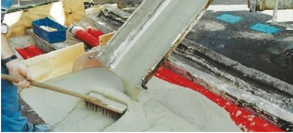
Isolation de canalisations ( \lambda=0.065 ) béton densité à partir de 300 kg/m 3 facilement escavable.
