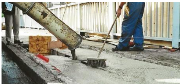
Trottoirs, gradins de stades, massifs artificiels, réduction de pression des pieds de talus. Densité à partir de 300 kg/m 3
